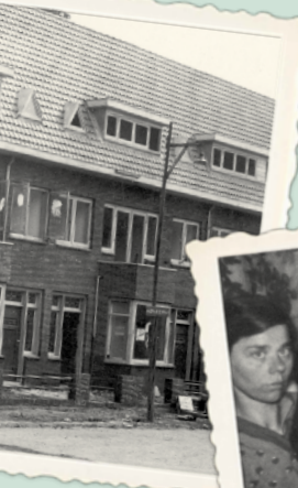
Gezinswoningen in aanbouw met erker, balkon en voortuintje, 1930.
